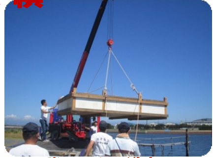
ポンツーンの進水
